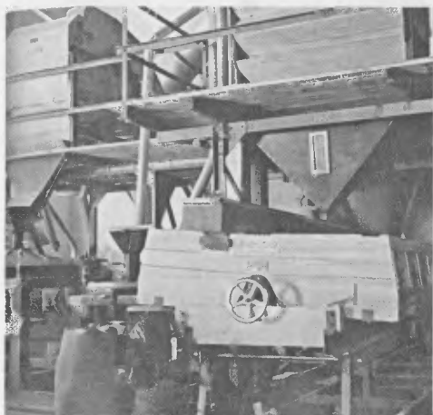
Une table à secousses opère un premier calibrage du riz « cargo »...
