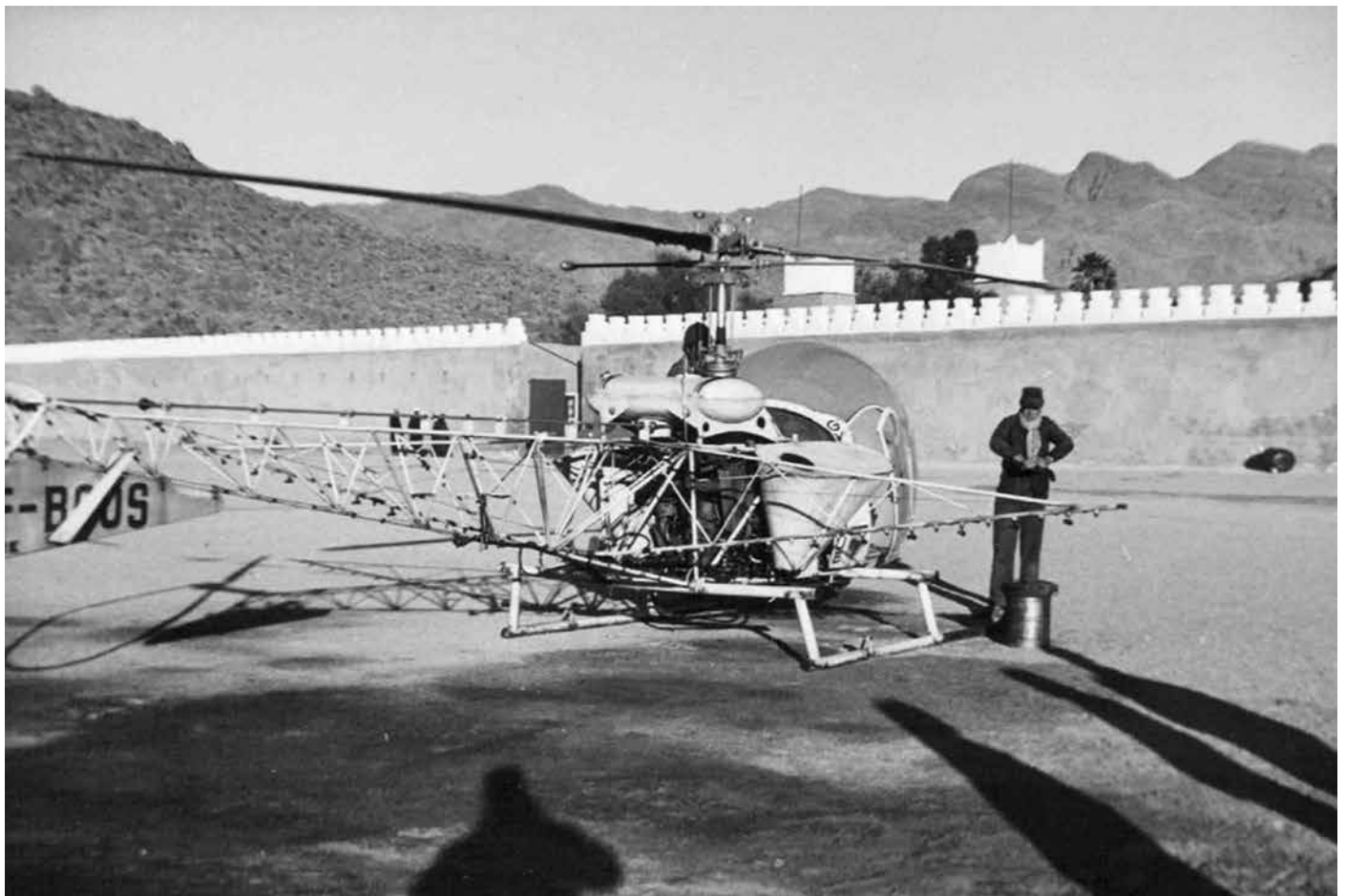
▼ À Taфраout (Maroc) en 1959, Bell avec les rampes de poudrage
