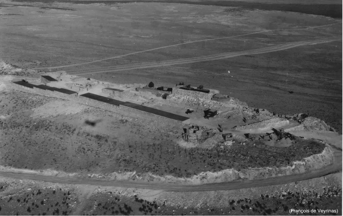
Barrage Ouest, poste SRG 2, 1958 – Le poste en construction, vu vers le sud-ouest
