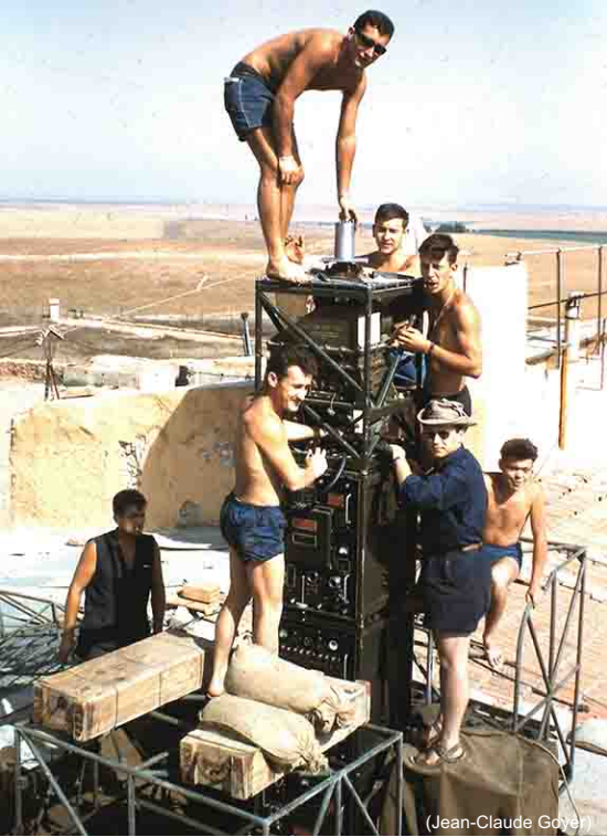
Barrage Ouest, démontage d'un radar de la station SRG 1 en juin 1962
