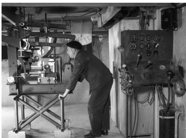
Figure 7 : salle du poste de commande du moteur et de la balance d'enregistrement des efforts pour essais statiques
