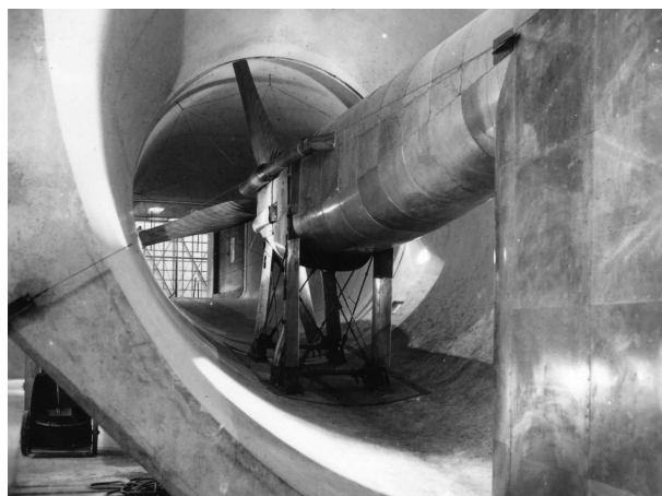
Figure 6 : le moteur avec son carénage et le ventilateur définitif à 4 pales (écoulement de 20 à 102 m/s)
