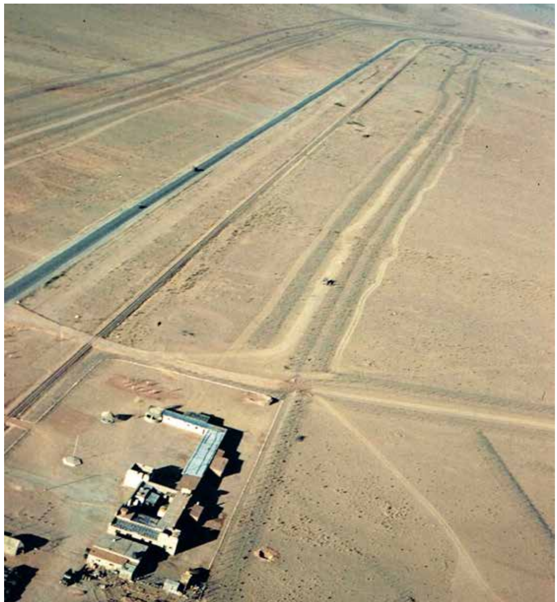
Le Barrage Ouest et la centrale d'El-Faidja
