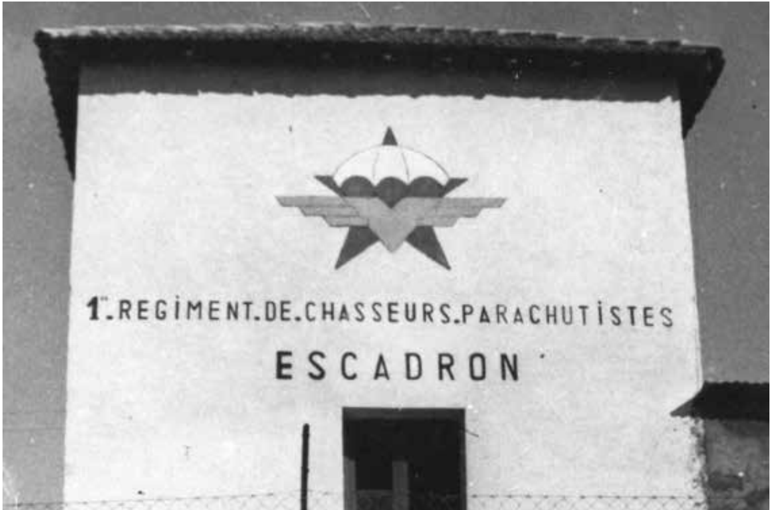
▼ Le poste de garde, construit par les gars de l'Escadron avec des matériaux récupérés en partie sur des ruines
