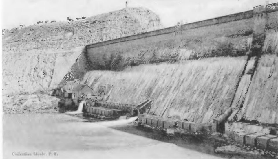
Le 10 mars 1872, une crue exceptionnelle estimée à 700 m<sup>3</sup>/s provoqua la rupture du déversoir en créant une brèche de 55 mètres de longueur sur 12 mètres de hauteur. Le débit d'eau sortant de la brèche fut évalué à 5 600 mètres cubes par seconde et plus de 200 000 m<sup>3</sup> de déblais furent entraînés.
