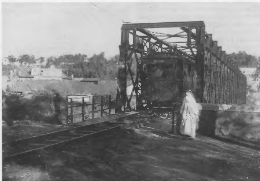
Pont des CFRA sur l'Oued Harrach, à Maison Carrée, avec une motrice électrique (Coll. R. Jung).
