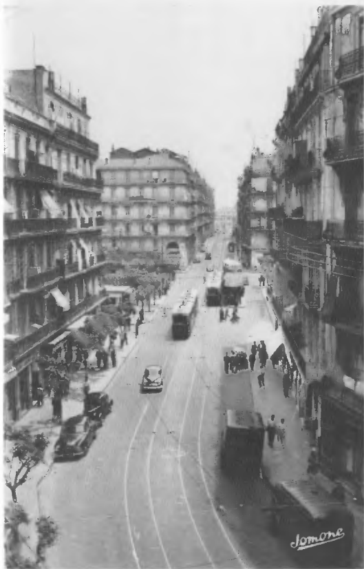
Alger - Avenues de la Marne et de la Bouzaréah
