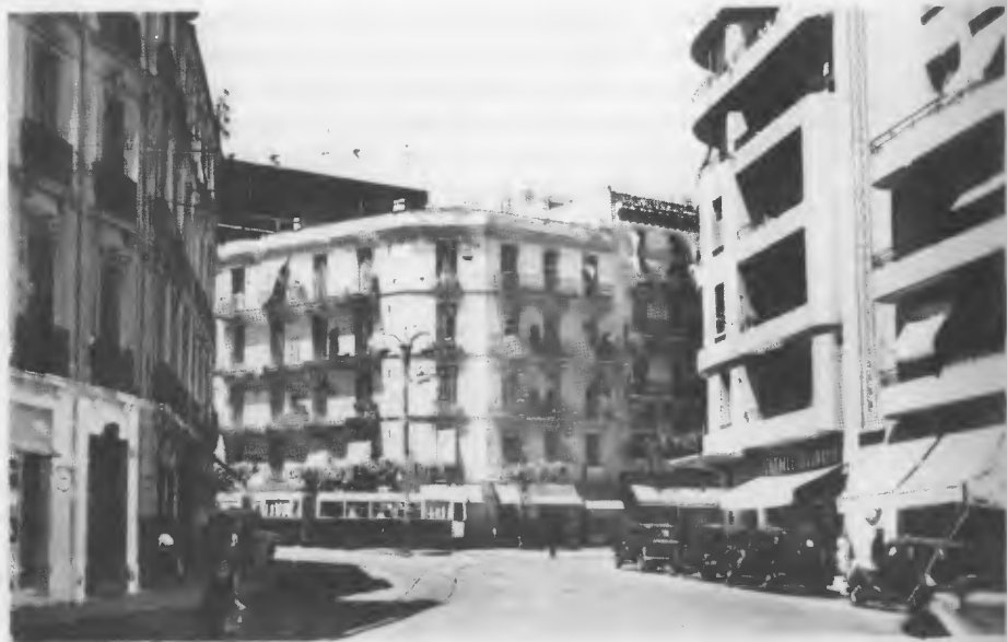
Alger - Bab-el-Oued - Carrefour du Boulevard de Provence et de l'Avenue des Consuls
