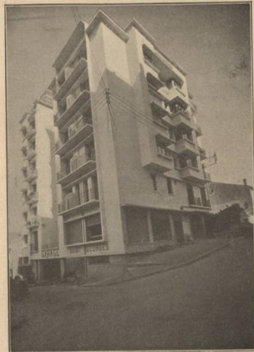
Immeuble, boulevard Saint-Simon et Saint-Beuve, à Alger. — Vue d'ensemble (Bétons armés Hennebique) (Ph. de Louvencourt, Alger)
