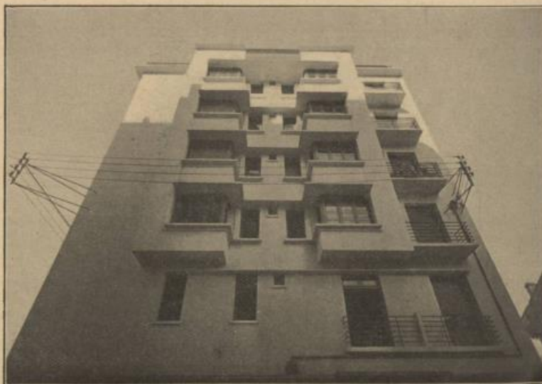
Immeuble, boulevard Saint-Simon et Saint- Beuve, à Alger. — Facade, vue prise du rez-de-chaussée
